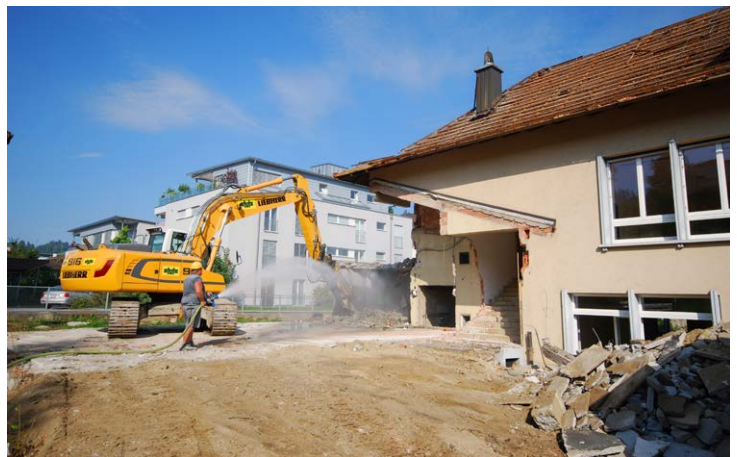
Das alte Pfarreiheim in Willisau wurde im September abgerissen. Die Kirchgemeinde baut auf dem Grundstück gemeinsam mit der Stadt und einem privaten Investor. Bild: Philipp Setz, Baureag AG
