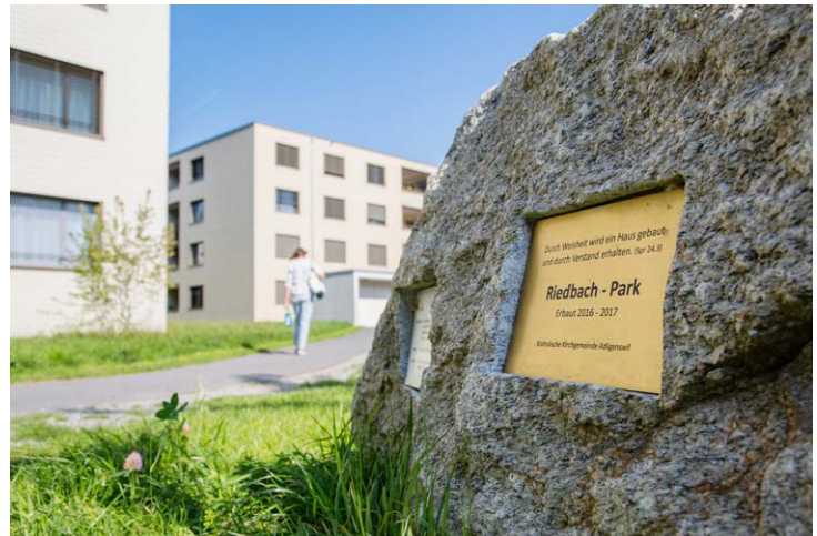
Hier hat die Kirche gebaut: Ein beschrifteter Stein im Riedpark in Adligenswil weist auf die Bauherrschaft hin. Bilder: Marcel Bucher
