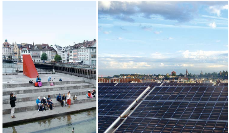
Das Wasserkraftwerk am Mühleplatz Luzern und die Fotovoltaikanlage auf der Dachterasse des EWL-Betriebsgebäudes. Die Landeskirche möchte auf Wasserstrom (2/3) und Solarstrom (1/3) umstellen. Bilder: EWL
